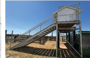
EXISTING PRESS BOX
